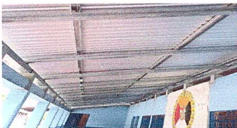
Foto 5: Estructura de techo de metal instalado.
