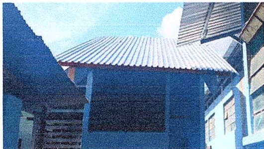
Foto1: Lámina Troquelada calibre 26 Instalada.
