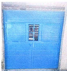
Foto 3: Puerta metal instalada.
