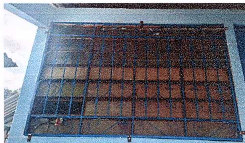
Foto 4: Balcón de ventana instalado.
