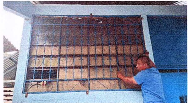
Foto 4: Intalación de ventana.
