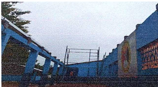
Foto 5: Servicio de Instalación de techo de soporte de metal.
