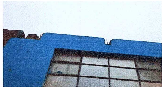
Foto 2: Retiro de la estructura de madera.
