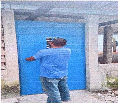
Foto 3: Instalación de puerta en la cocina.
