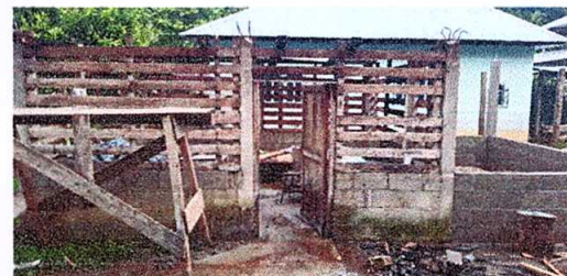
Foto. 6; Área de cocina en proceso de mejoramiento.
