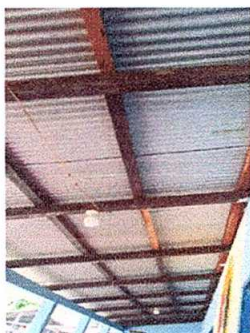
Foto 5: Servicio de Instalación de techo de soporte de metal.
