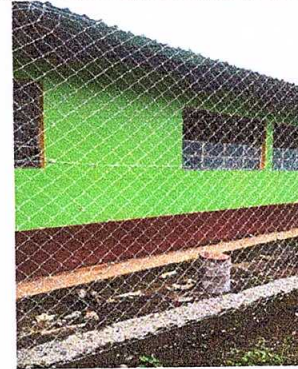
Foto8: Reparación de malla galvanizada
