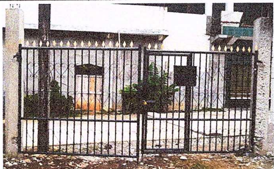
Foto 5: Sustitución de portón
