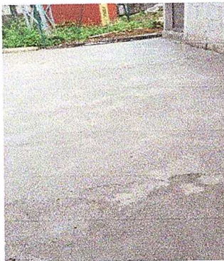
Foto9: Reparación de plancha de concreto de patio
