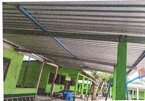
Foto10: Sustrución de lámina, por lámina troquelada
