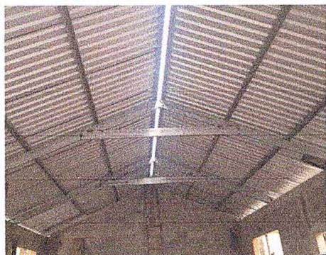
Foto1: Sustitución de lámina, por lámina troquelada calibre 26
