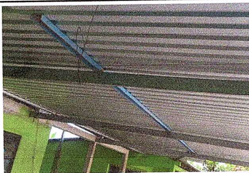
Foto11: Sustrución de soporte de madera por metal.
