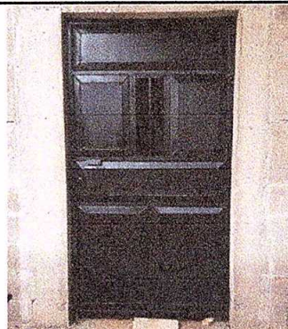
Foto 4: Sustitución de puerta de madera por metal
