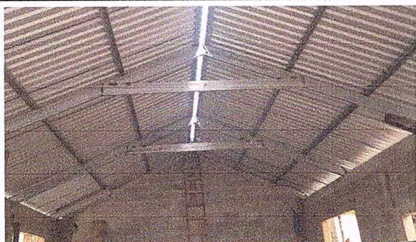
Foto 3: Sustitución de soporte de madera por metal.
