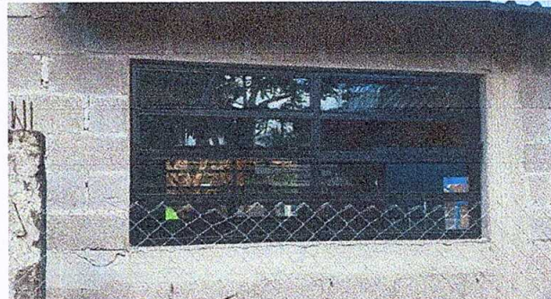
Foto 6: Sustitución de ventanas de madera por metal
