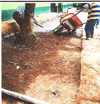
Foto9: Reparación de plancha de concreto de patio
