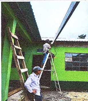
Foto11: Sustrucción de soporte de madera por metal.
