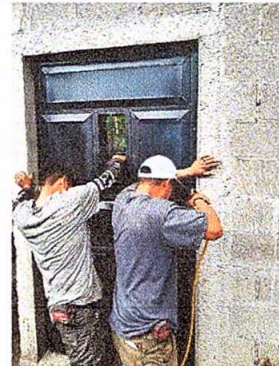
Foto 4: Sustitución de puerta de madera por metal
