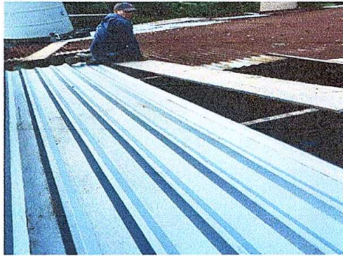
Foto1: Sustitución de lámina, por lámina troquelada calibre 26
