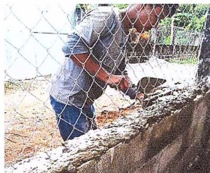
Foto8: Reparación de malla galvanizada
