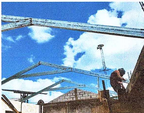
Foto 3: Sustitución de soporte de madera por metal.
