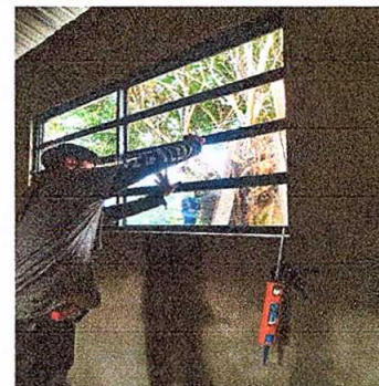
Foto 6: Sustitución de ventanas de madera por metal
