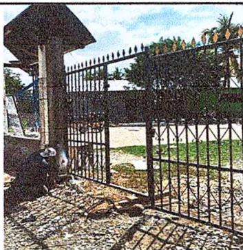
Foto 5: Sustitución de portón
