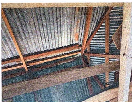
Foto 3: Sustitución de soporte de madera por metal.
