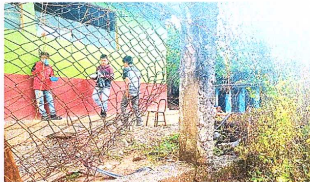
Foto8: Reparación de malla galvanizada
