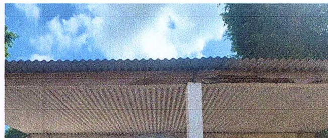
10: Sustitución de lámina, por lámina troquelada
