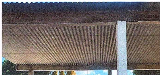
Foto11: Sustitución de soporte de madera por metal.
