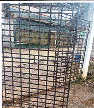
Foto 5: Sustitución de portón
