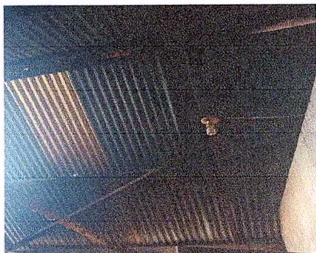
Foto1: Sustitución de lámina, por lámina troquelada calibre 26
