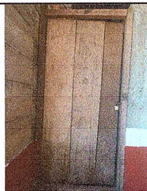
Foto 4: Sustitución de puerta de madera por metal
