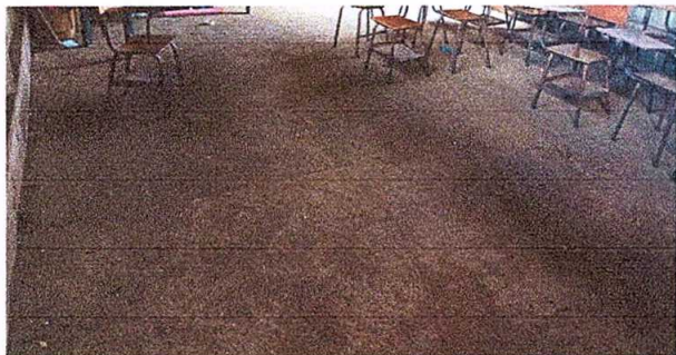
Foto7: Sustitución de piso de concreto o granito.
