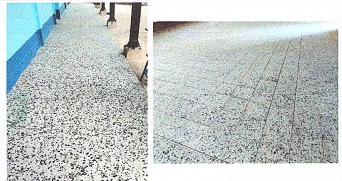
Foto 5: Sustitución de piso de granito
