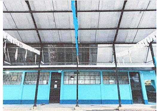
Foto8: Pintura en muros exteriores e interiores
