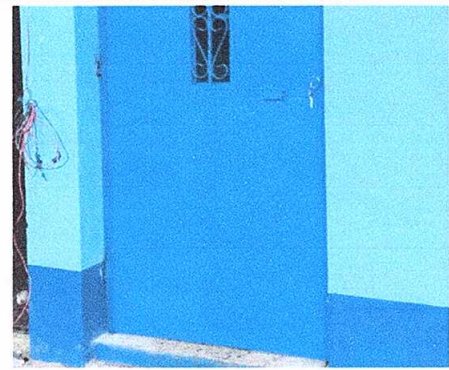
Foto 6: Sustitución de puerta (2.10m de alto * 1.00m de ancho)
