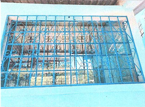
Foto6: Sustitución de estructura de metal de ventana (1.5m*1m)
