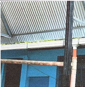
Foto 3: Sustitución de bajada de agua pluvial
