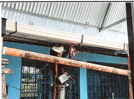
Foto 3: Sustitución de bajada de agua pluvial
