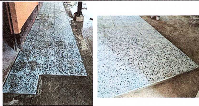
Foto 5: Sustitución de piso de granito
