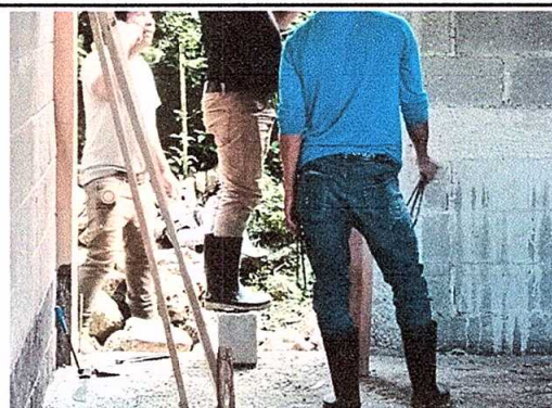
Foto 6: Sustitución de puerta (2.10m de alto * 1.00m de ancho)
