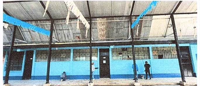
Foto8: Pintura en muros exteriores e interiores
