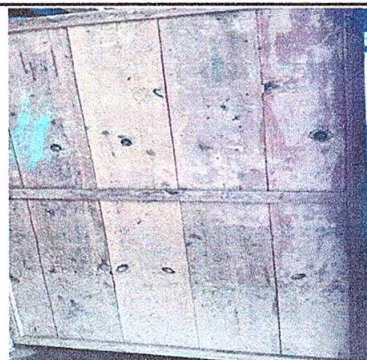
Foto 6: Sustitución de puerta (2.10m de alto * 1.00m de ancho)
