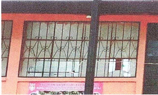
Foto6: Sustrucción de estructura de metal de ventana (1.5m*1m)
