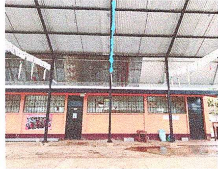
Foto8: Pintura en muros exteriores e interiores
