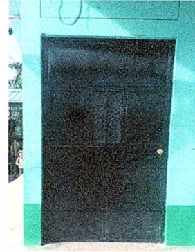
FOTO No. 2: Sustrucción de puerta de metal (2.11m de alto * 1m de ancho)
