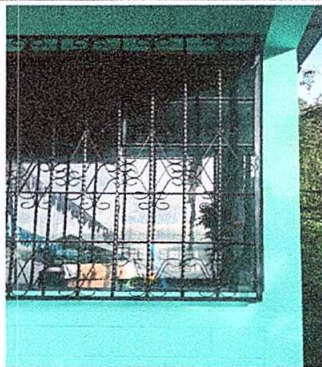
FOTO No. 3: Mantenimiento a estructura de metal de ventana
