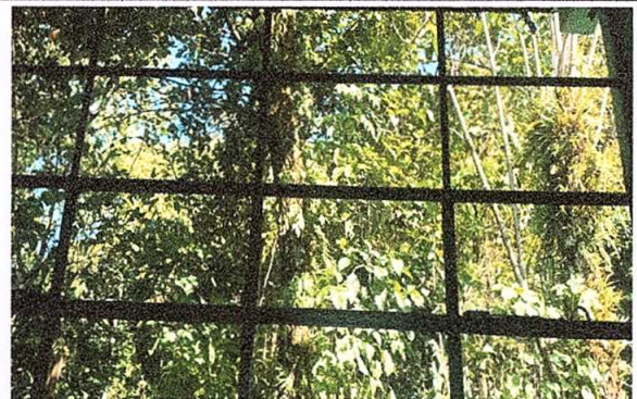
FOTO No. 4: Sustrucción de vidrios
