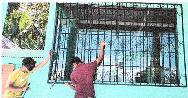
FOTO No. 5: Mejoramiento de balcones de metal
