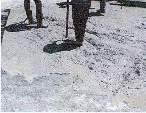
FOTO No. 7: Reparación de planchas de concreto de patio
