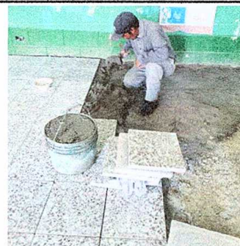
FOTO No. 6: Sustitución de piso de granito
