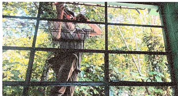
FOTO No. 4: Sustitución de vidrios
