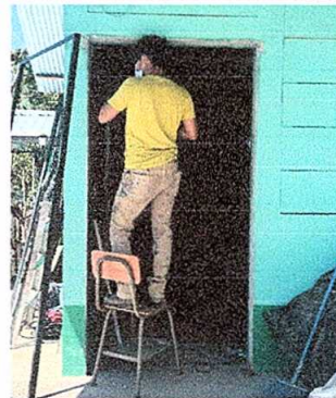
FOTO No. 2: Sustitución de puerta de metal (2.11m de alto * 1m de ancho)
