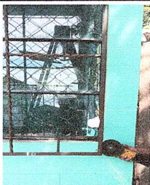
FOTO No. 3: Mantenimiento a estructura de metal de ventana
