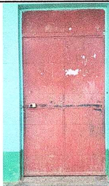
FOTO No. 1: Sustitución de puerta de metal (2.38m de alto * 1.17m de ancho)
