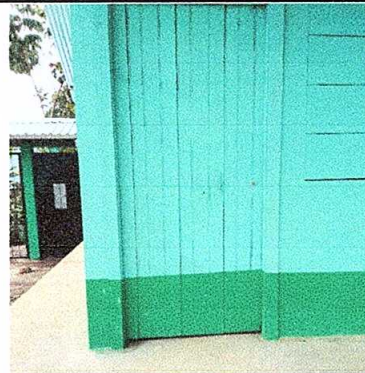
FOTO No. 2: Sustitución de puerta de metal (2.11m de alto * 1m de ancho)
