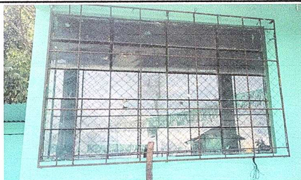
FOTO No. 5: Mejoramiento de balcones de metal
