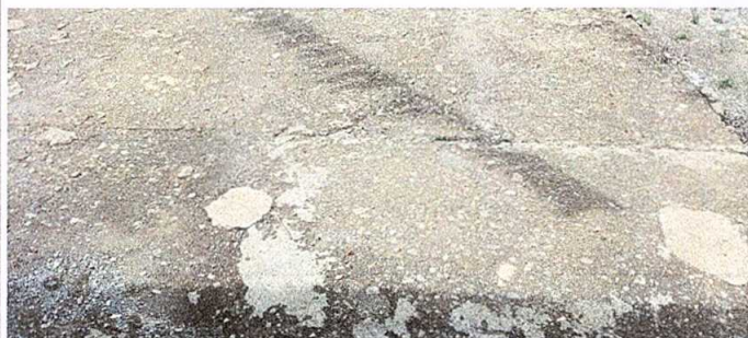
FOTO No. 7: Reparación de planchas de concreto de patio
