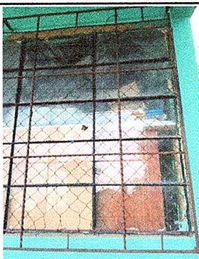
FOTO No. 3: Mantenimiento a estructura de metal de ventana
