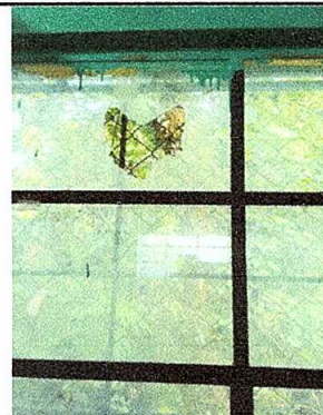
FOTO No. 4: Sustitución de vidrios
