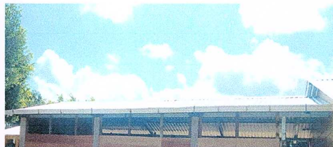
Foto 4: Sustitución de canal de pvc
