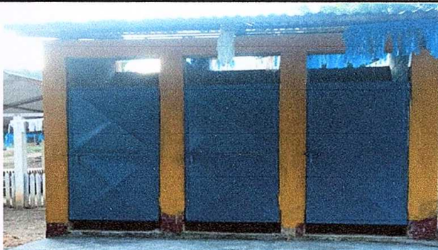
Foto 6: Sustitución de puerta (0.80m * 1.60m)
