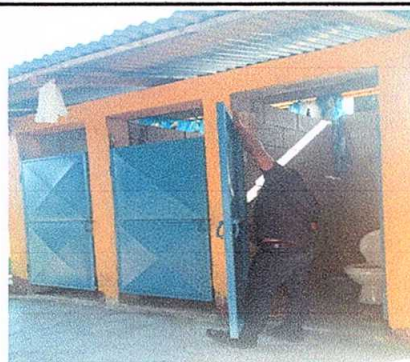
Foto 6: Sustitución de puerta (0.80m * 1.60m)
