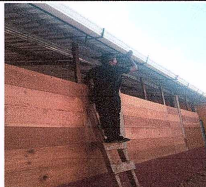
Foto 4: Sustitución de canal de pvc
