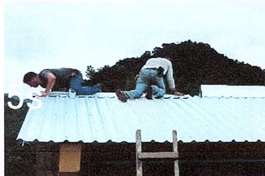
Foto 2: Sustitución de capote de lámina para lámina troquelada
