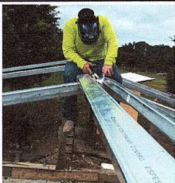
Foto 3: Sustitución de estructura de soporte de madera, por metal
