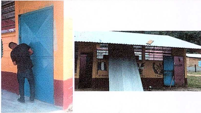
Foto7: Sustitución de puerta (1m * 2.10m)
