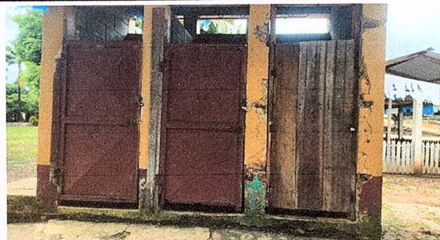
Foto 6: Sustitución de puerta (0.80m * 1.60m)
