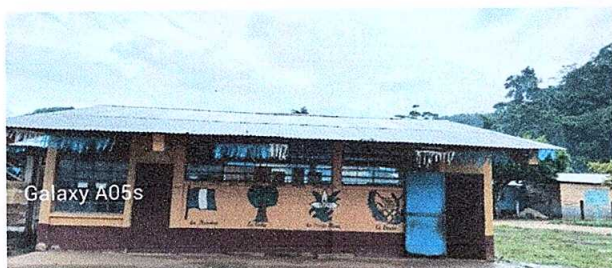
Foto1: Sustitución de lámina, por lámina troquelada aluzinc calibre 26
