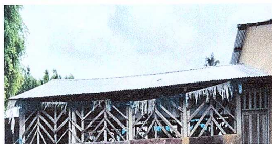
Foto 4: Sustitución de canal de pvc
