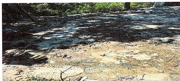
Foto 5: Sustitución de piso de torta de concreto
