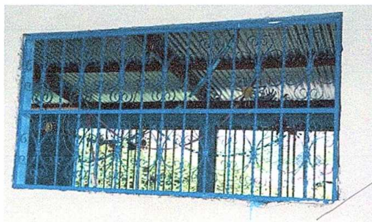
Foto 3: Sustitución de balcones de madera por balcones de metal.
