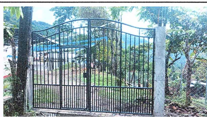
Foto 2: Sustitución de portón de lámina y madera por metal de 3.5 metros por 2.5 metros
