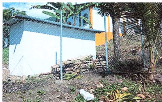
Foto 6: Reparación de tubo hg y malla galvanizada.
