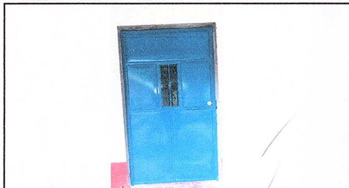
Foto1: Sustitución de puerta de madera por metal de 2.00 metros x 1.00 metro
