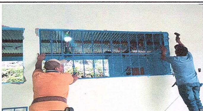
Foto 3: Sustitución de balcones de madera por balcones de metal.
