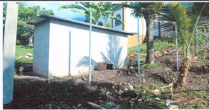
Foto 6: Reparación de tubo hg y malla galvanizada.
