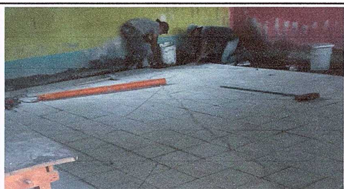
Foto 4: Sustitución de piso de concreto por piso granito.
