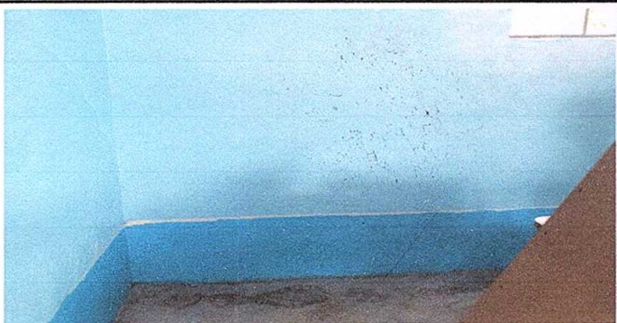
Foto 5: Pintura de muros interiores.
