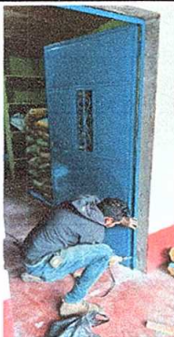
Foto 1: Sustitución de puerta de madera por metal de 2.00 metros x 1.00 metro
