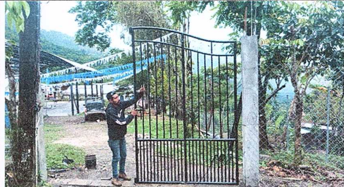
Foto 2: Sustitución de portón de lámina y madera por metal de 3.5 metros por 2.5 metros
