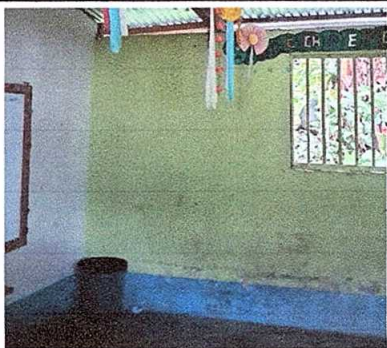
Foto 5: Pintura de muros interiores.
