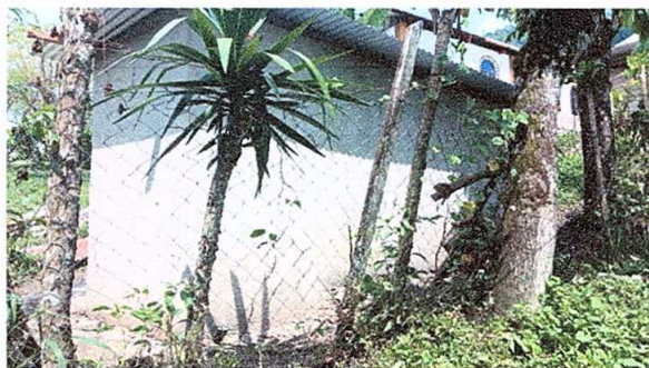
Foto 6: Reparación de tubo hg y malla galvanizada.
