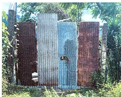
Foto 2: Sustrucción de portón de lámina y madera por metal de 3.5 metros por 2.5 metros
