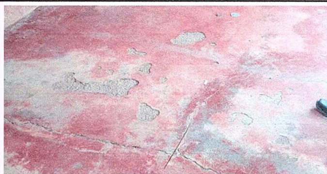
Foto 4: Sustrucción de piso de concreto por piso granito.
