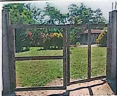
Foto 9: Sustrucción de portón
