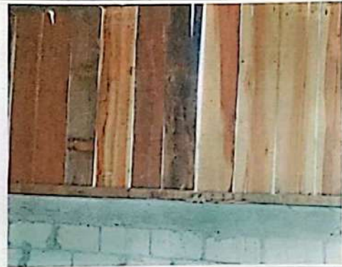
Foto 4: Sustrución de ventana de madera por ventana metálica
