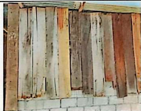
Foto 6: Mejoramiento de pared en cocina
