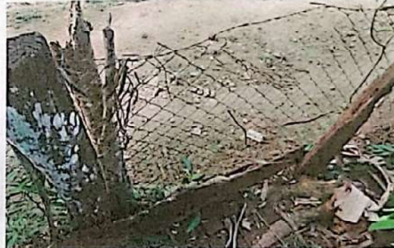
Foto 10: Sustrucción de poste de madera y malla
