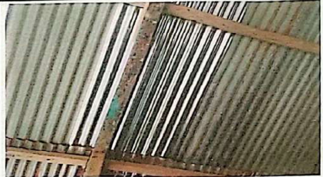
Foto 2: Sustrución de estructuras de soporte
