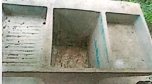
Foto 8: Sustrucción de pila
