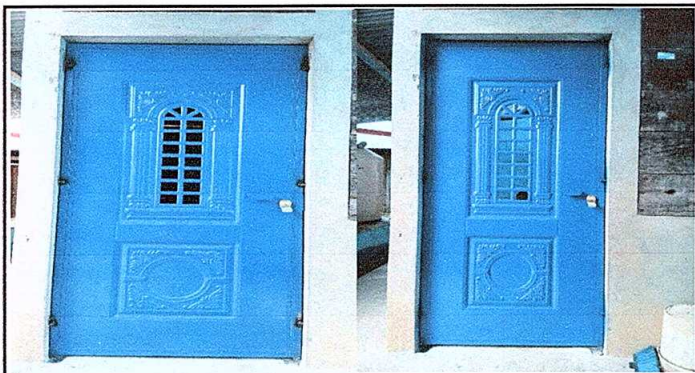
Foto 3: Sustitución de puerta de metal (2.10m de alto y 1.00m de ancho)
