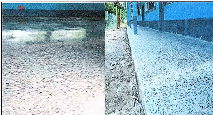
Foto1: Sustitución de piso de granitos de la Escuela.
