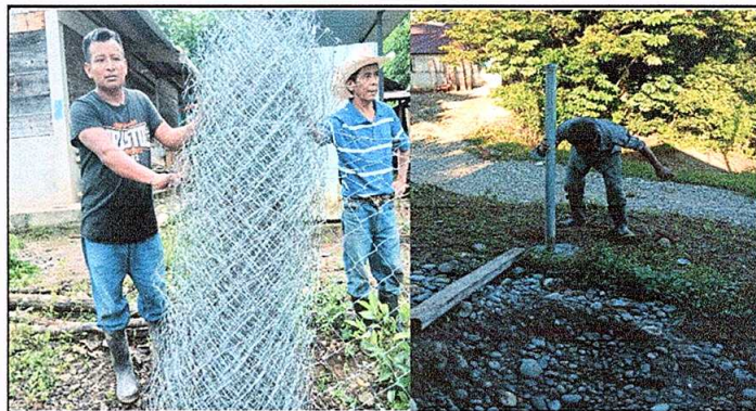
Foto 2: Reparación de tubo gh y malla galvanizada de 1.5m
