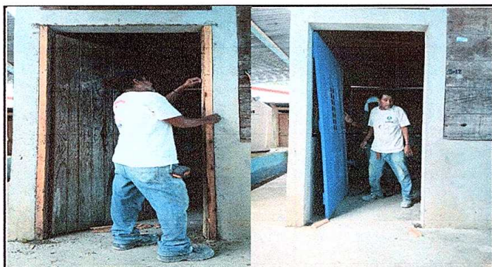
Foto 3: Sustitución de puerta de metal (2.10m de alto y 1.00de ancho)
