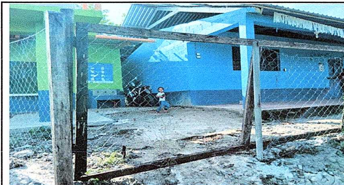
Foto 4: Sustrucción de portón de madera por metal (2m de alto y 3.30m de ancho)
