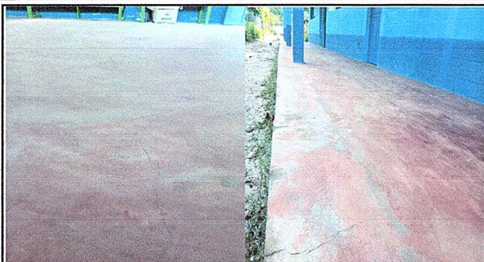
Foto 1: Sustrucción de piso de cemento líquido por piso de granito
