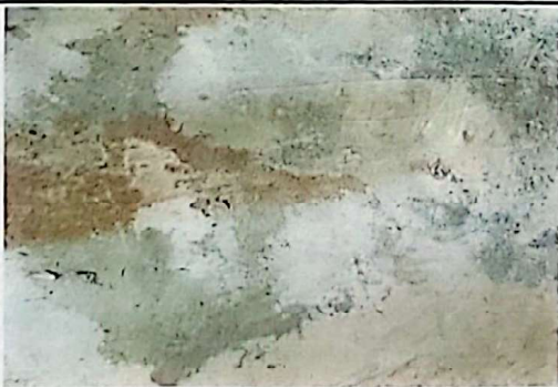
Foto 5: Sustitución de piso de granito
