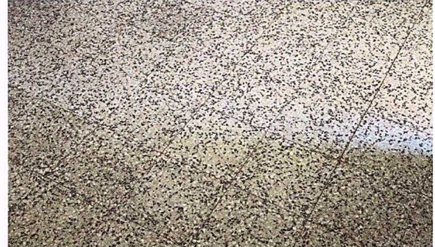
Foto 2: Sustitución de piso de torta de concreto por piso de granito
