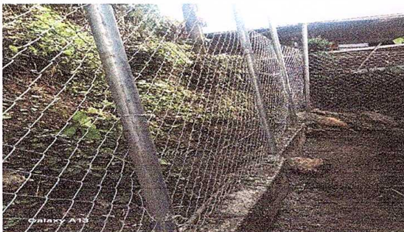
Foto 5: Reparación de muro perimetral con malla galvanizada
