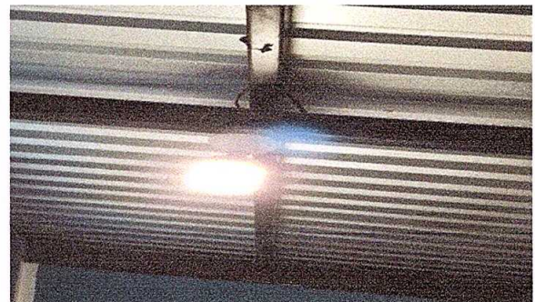
Foto 4: Reparación de sistema eléctrico
