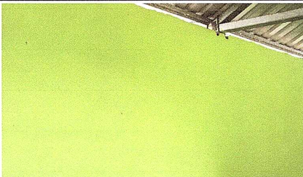
Foto 3: Reparación de repello y cernido de paredes.
