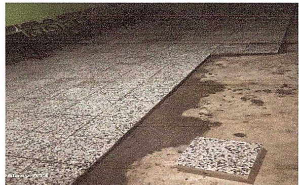
Foto 2: Sustrucción de piso de torta de concreto por piso de granito
