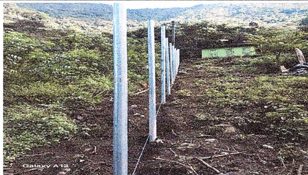
Foto 5: Reparación de muro perimetral con malla galvanizada
