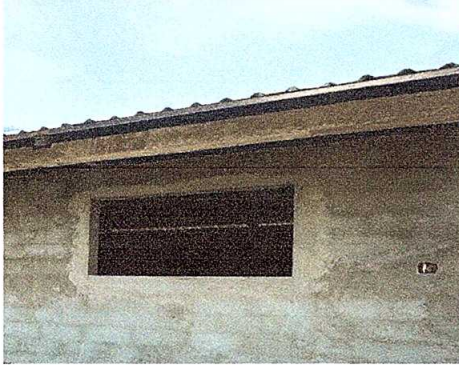
Foto 1: Sustrucción de ventanas de madera por PVC con vidrio de 1.50 por 2 Mts.
