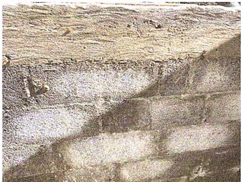
Foto 3: Reparación de repello y cernido de paredes.
