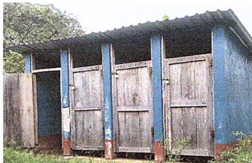
Foto 6: Reparación de servicios sanitarios
