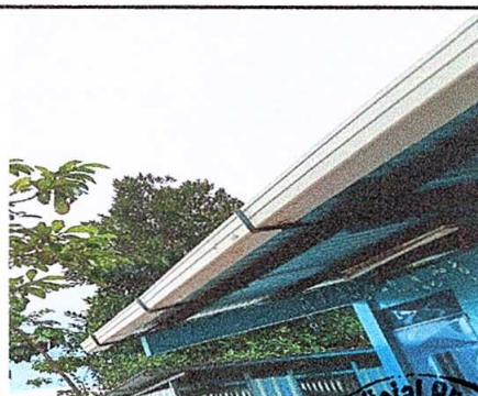
Foto 6: Sustrución de canales
