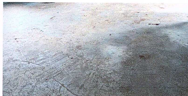
Foto 10: Mejoramiento de piso (Cocina)
