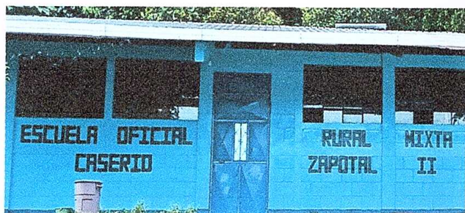
Foto 7: Sustitución de pintura
