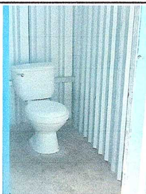
Foto 3: Sustrución de inodoro
