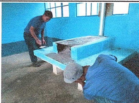
Foto 5: Sustitución de plancha
