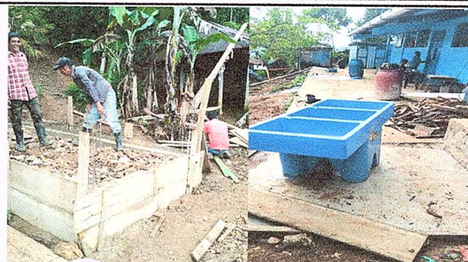
Foto 2: Sustitución de pilas de madera
