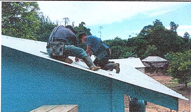
Foto 1: Sustitución de lámina de cocina
