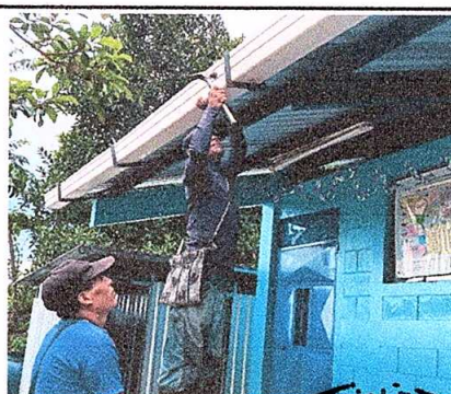
Foto 6: Sustitución de canales
