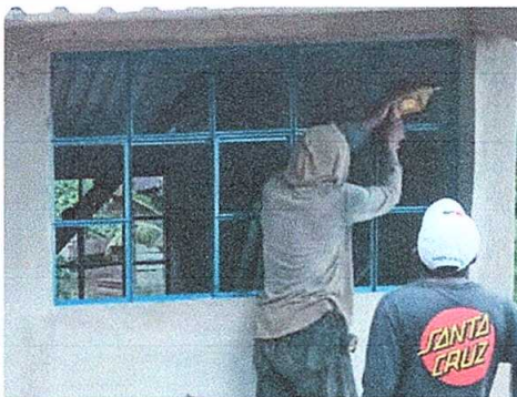
Foto 9: Sustitución de ventanas
