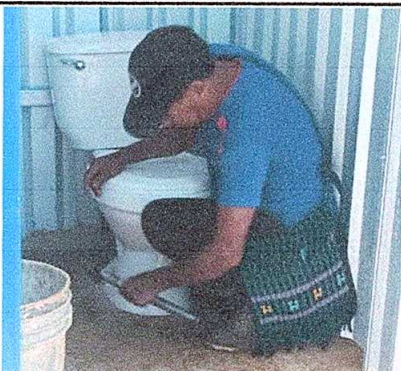
Foto 3: Sustitución de inodoro
