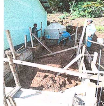
Foto 8: Sustitución de depósito de agua 2500Lt
