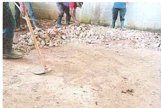
Foto 10: Mejoramiento de piso (Cocina)
