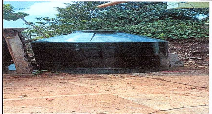
Foto 2: sustitución de deposito de agua 2500Lt
