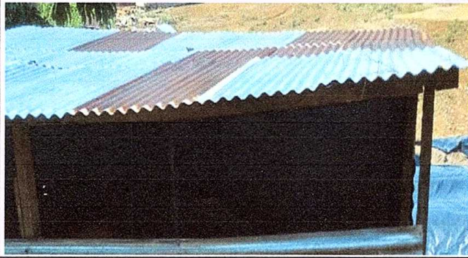
Foto 1: Sustitución de laminas de cocina
