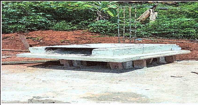
Foto 5: Sustitución de plancha
