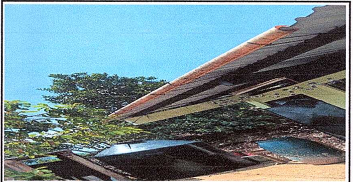
Foto 6: Sustitución de canales
