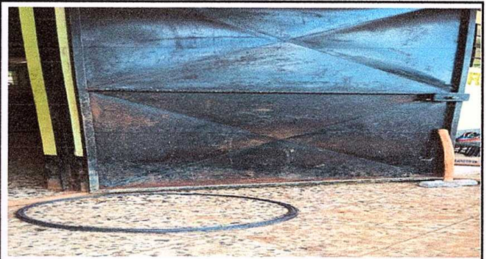
Foto 4: Sustitución de puertas
