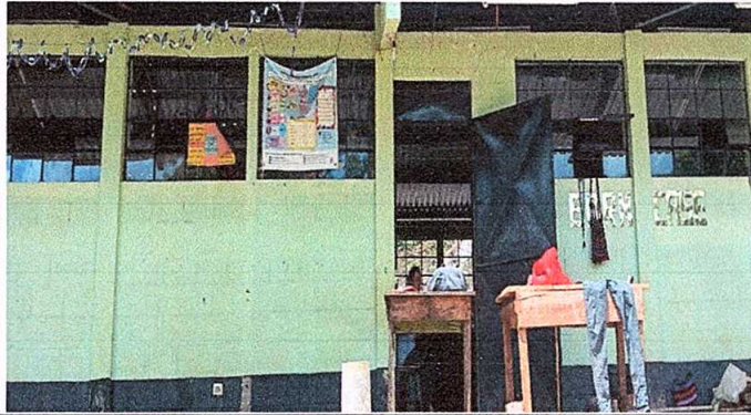
Foto1: Sustitución de pintura
