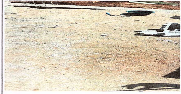
Foto 4: Mejoramiento de piso (Cocina)
