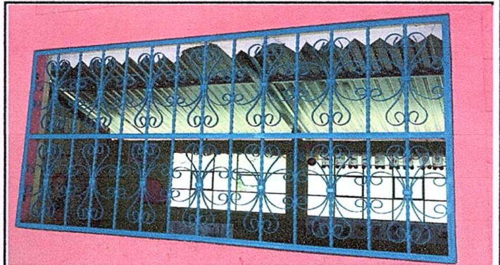
Foto 4: Sustitución de balcones de madera por metal
