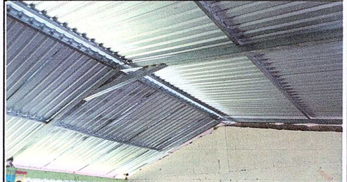
Foto 2: Sustitución de estructura de madera por metal
