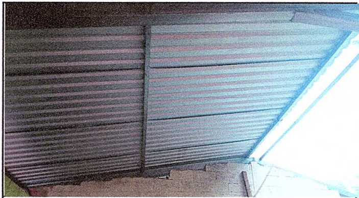
Foto 2: Sustitución de estructura de madera por metal
