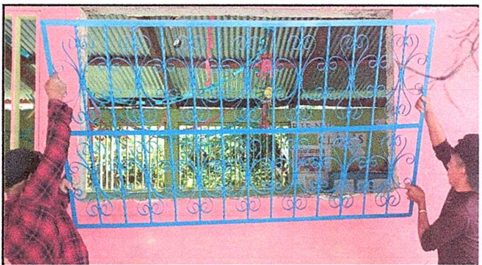
Foto 4: Sustitución de balcones de madera por metal
