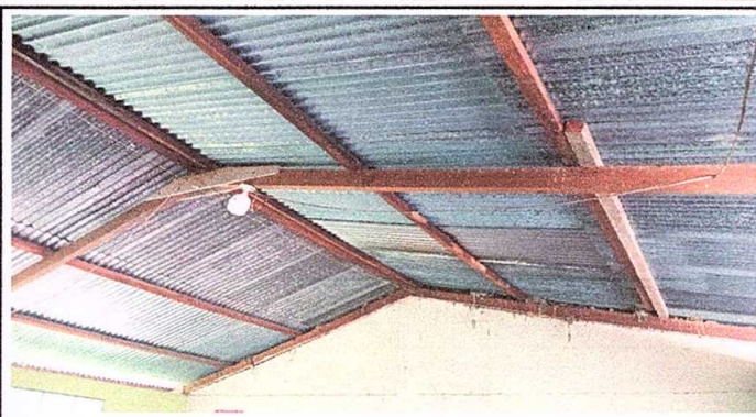
Foto 2: Sustitución de estructura de madera por metal
