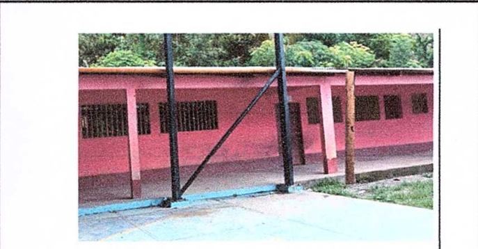
Foto 6: sustitución de bajada de agua
