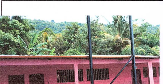
Foto 5: Sustitución de canal de pvc
