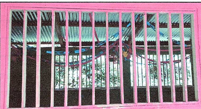
Foto 4: Sustitución de balcones de madera por metal
