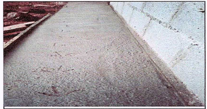
Foto 6: Banqueta de concreto finalizado
