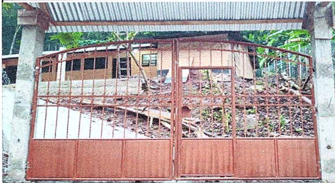
Foto 1: Portón de metal colocado
