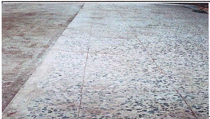
Foto 3: Colocación de piso granito finalizado
