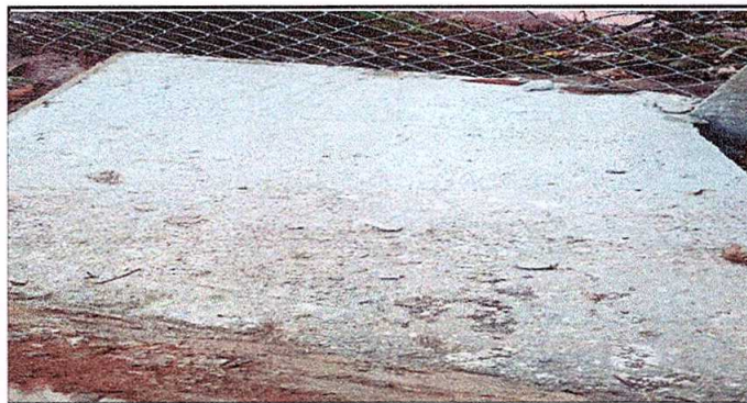
Foto 5: Plancha de concreto a cuneta colocado
