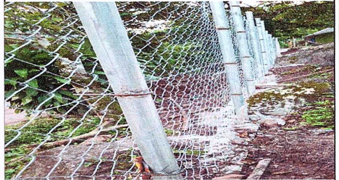
Foto 2: Muro perimetral colocado
