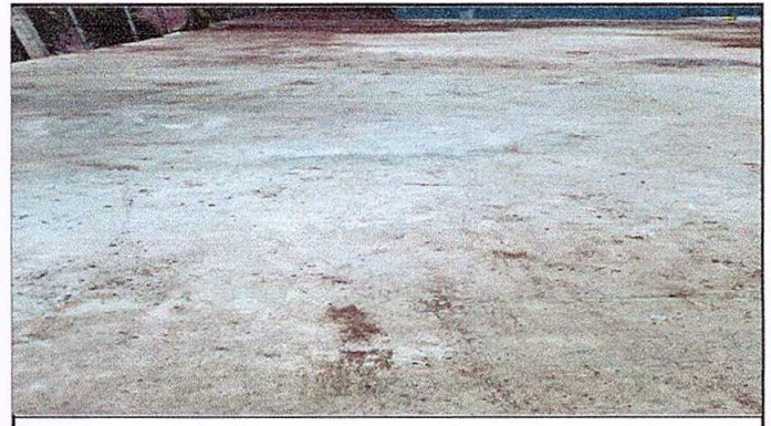
Foto 4: Piso de concreto colocado
