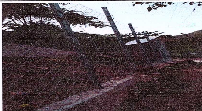
Foto 2: colocación de malla perimetral
