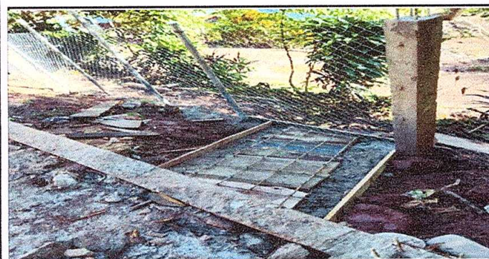
Foto 5: Colocación de plancha de concreto a cuneta
