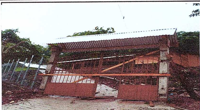
Foto1: Colocación de portón
