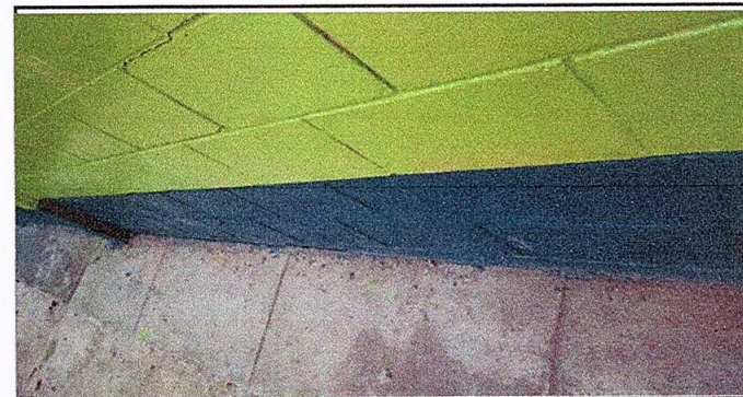
Foto 6: Colocacion de banqueta de concreto
