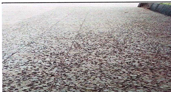
Foto 3: colocación de piso granito
