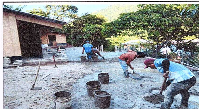
Foto 4: sustitucion de piso de concreto deteriorado
