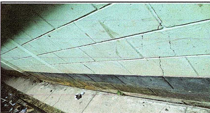
Foto 6 Reparacion de banqueta de concreto
