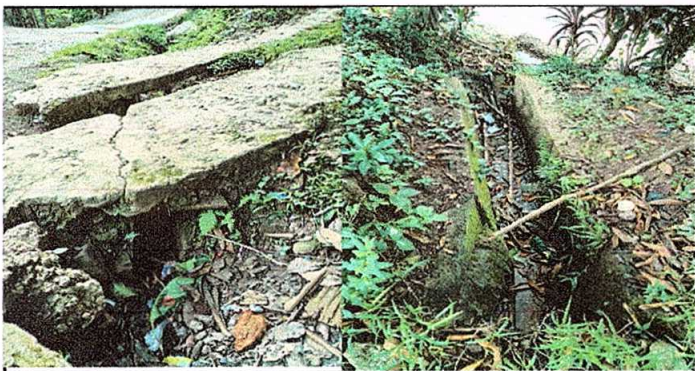
Foto 5 Reparación de cuneta de concreto
