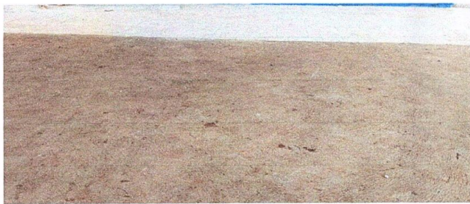
Foto 3: REPARACIÓN DE PLANCHAS DE CONCRETO EN PATIO
