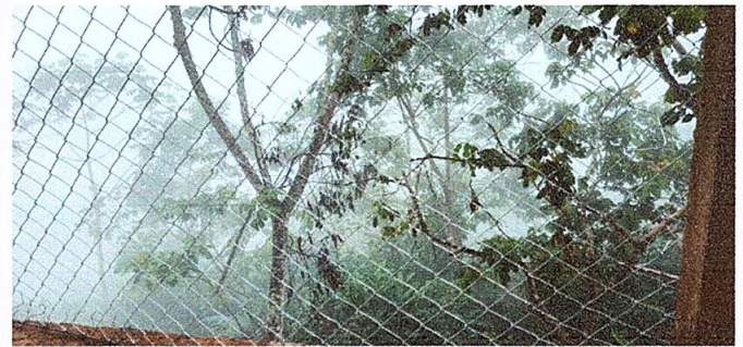
Foto 4: REPARACIÓN DE TUBO HG Y MALLA GALVANIZADA
