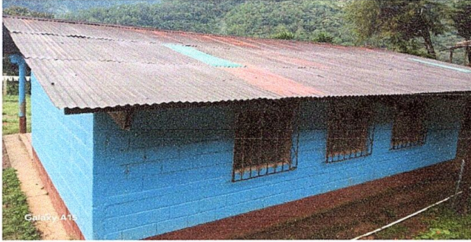
Foto1: SUSTITUCIÓN DE LÁMINA
