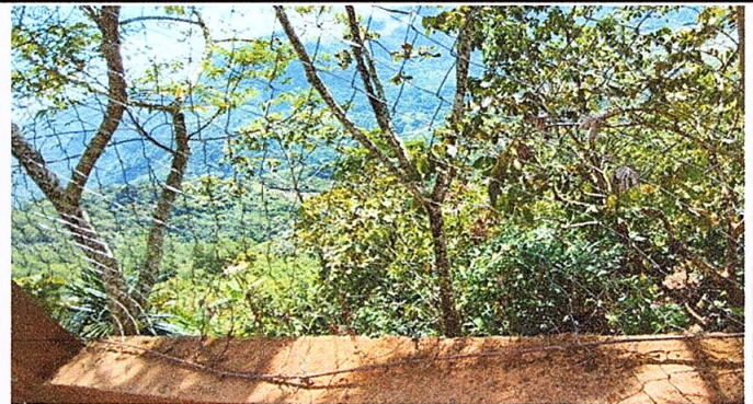
Foto 4: REPARACIÓN DE TUBO HG Y MALLA GALVANIZADA
