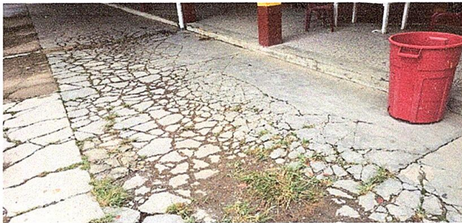
Foto 3: REPARACIÓN DE PLANCHAS DE CONCRETO EN PATIO
