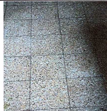
Foto 6: Sustitución de piso de granito
