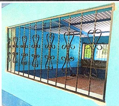
Foto 5: Sustitución de balcones de metal
