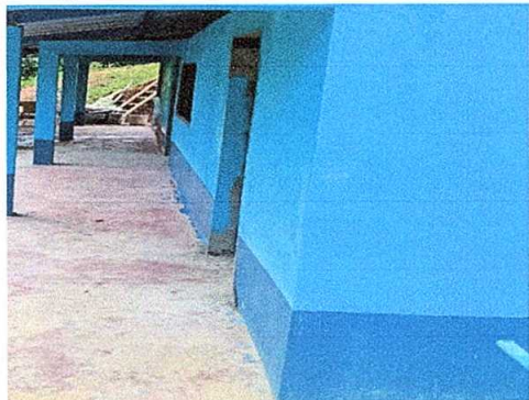
Foto 7: Pintura en muros exteriores e interiores
