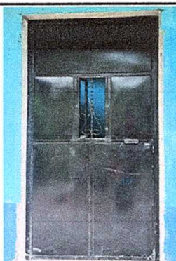
Foto 3: Sustitución de puerta (2.20m de alto * 1.00m de ancho)
