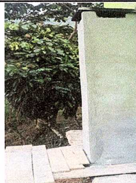
Foto 8: Sustitución de chimenea de concreto
