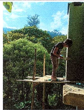
Foto 8: Sustitución de chimenea de concreto
