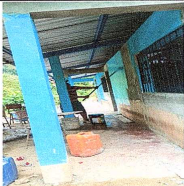
Foto 7: Pintura en muros exteriores e interiores
