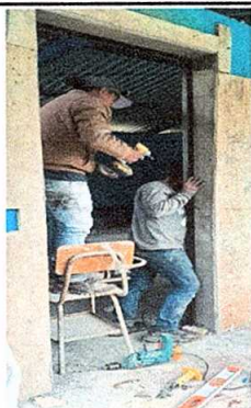
Foto 3: Sustitución de puerta (2.20m de alto * 1.00m de ancho)
