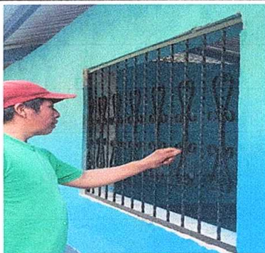
Foto 5: Sustitución de balcones de metal
