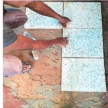
Foto 6: Sustitución de piso de granito
