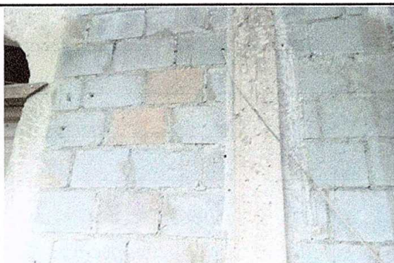
Foto 9: Repello en muro
