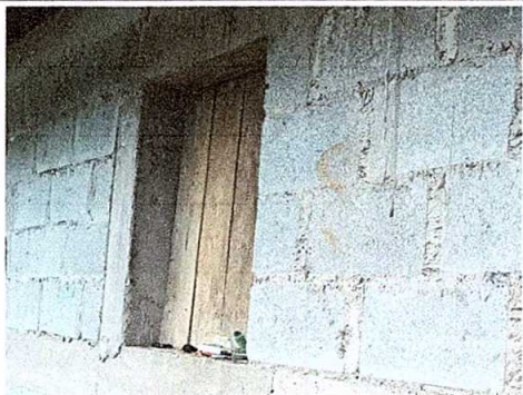
Foto 5: Sustitución de balcones de metal
