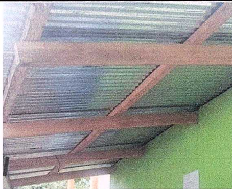
Foto 2: Sustitución de estructura de soporte de madera, por metal
