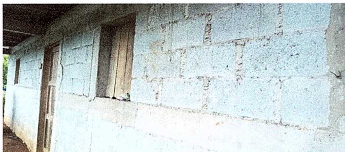
Foto 7: Pintura en muros exteriores e interiores
