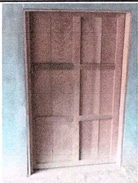
Foto 3: Sustitución de puerta (2.20m de alto * 1.00m de ancho)
