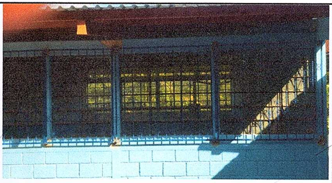
Foto 4: Sustitución de balcones de metal
