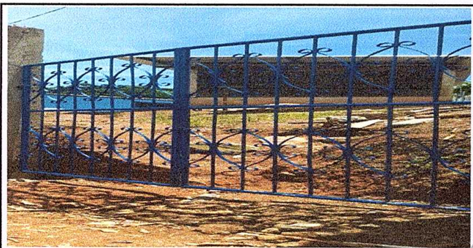
Foto 5: Sustitución de portón de madera por metal
