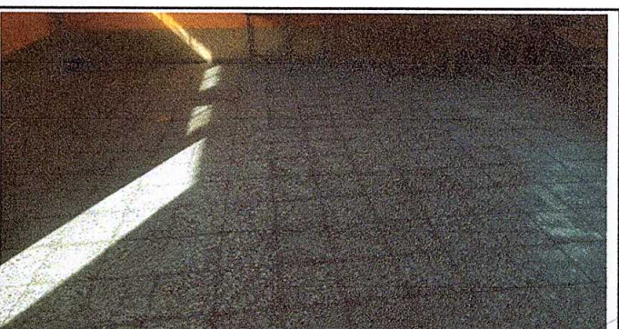
Foto 6: Sustitución de piso de concreto por piso de granito
