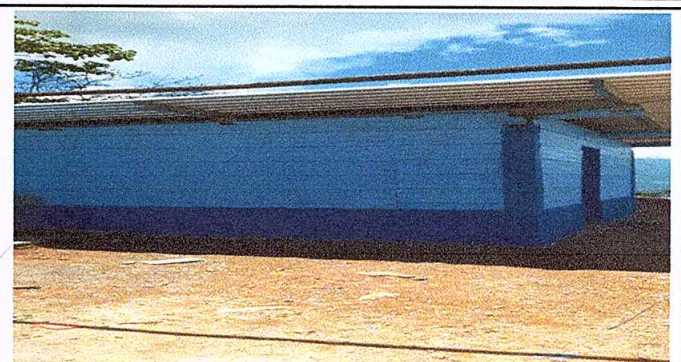
Foto 2: Sustitución de lámina y estructura de techo de cocina
