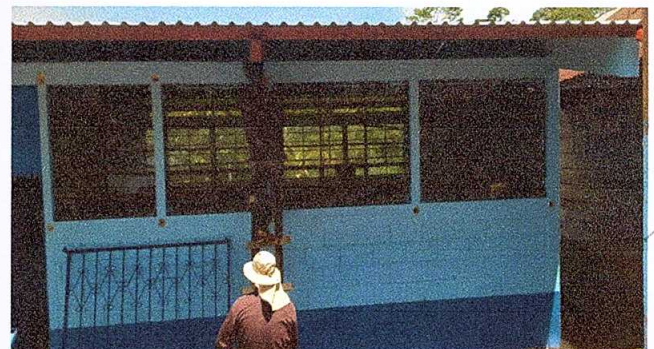
Foto 4: Sustitución de balcones de metal
