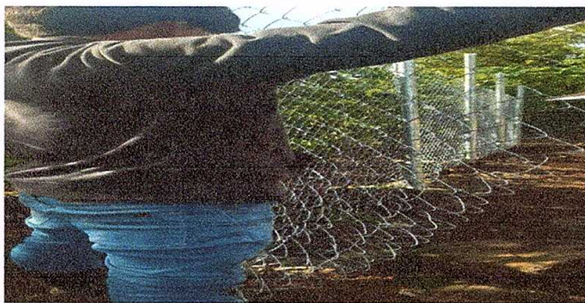
Foto 3: Sustitución de circulación de madera por tubo hg y malla galvanizada
