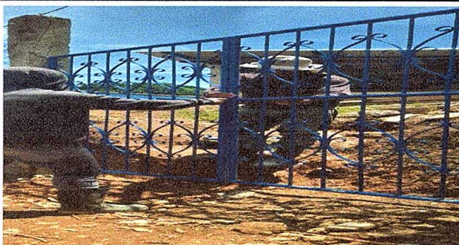
Foto 5: Sustitución de portón de madera por metal
