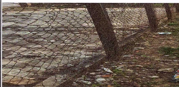
Foto 3: Sustitución de circulación de madera por tubo hg y malla galvanizada
