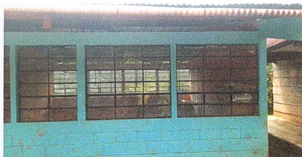
Foto 4: Sustitución de balcones de metal
