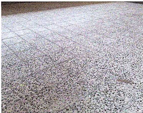
Foto 3: Piso de granito finalizado.
