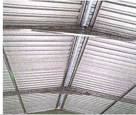
Foto 2: Estructura de soporte de techo nueva.
