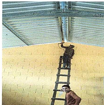
Foto 2: Colocando Estructura de soporte de techo.
