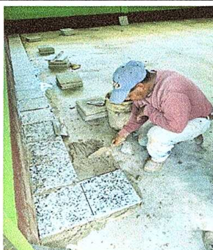
Foto 3: Colocando piso de granito.
