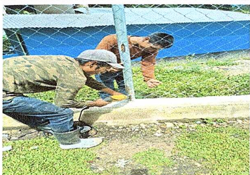
Foto 5: Colocando la malla.
