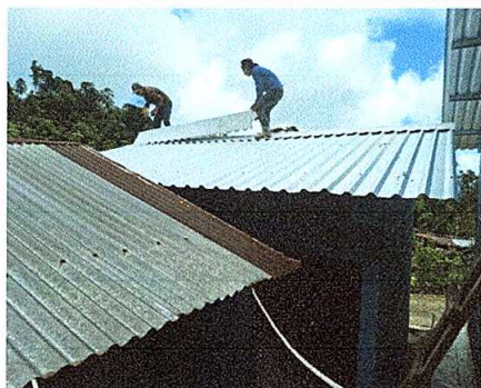
Foto1: Colocando el techo.
