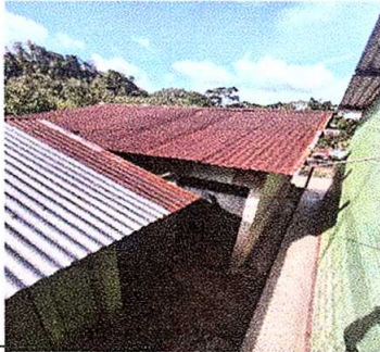
Foto1: láminas en malas condiciones
