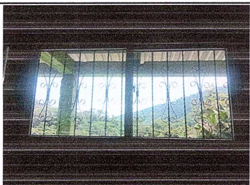
Foto 3: Sustitución de ventanas de madera por metal mas vidrio de 5 mts. de alto x 1 mt. de ancho
