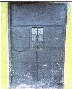
Foto 5: Sustitución de puerta de madera a metal de 2.20 mts. de alto x 1.00 mt. de ancho
