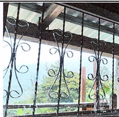
Foto 4: Sustitución de balcones de metal de 6 mts. de alto x 1.5 mts. de ancho
