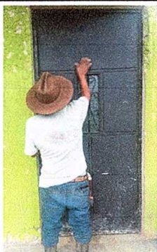
Foto 5: Sustitución de puerta de madera a metal de 2.20 mts. de alto x 1.00 mt. de ancho
