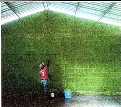
Foto 7: Pintura en muros exteriores e interiores
