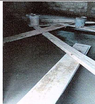
Foto 6: Sustitución de piso de torta de concreto
