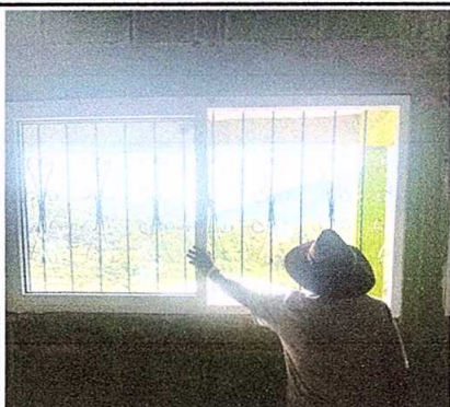
Foto 3: Sustitución de ventanas de madera por metal mas vidrio de 5 mts. de alto x 1 mt. de ancho
