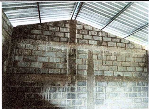
Foto 7: Pintura en muros exteriores e interiores
