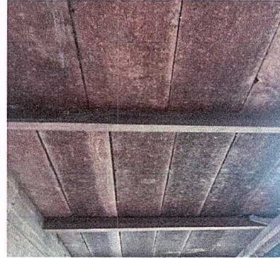
Foto 2: Sustrucción de estructura de soporte de madera, por metal
