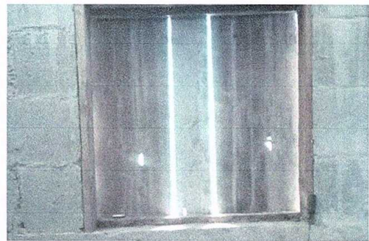
Foto 4: Mejoramiento con balcones de metal de 6 mts. de alto x 1.5 mts. de ancho
