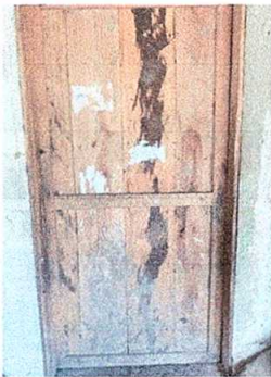
Foto 5: Sustrucción de puerta de madera a metal de 2.20 mts. de alto x 1.00 mt. de ancho
