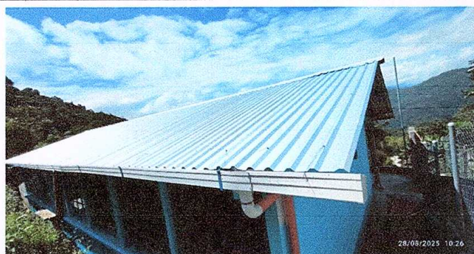
Foto1: CUBIERTA DE LAMINAS
