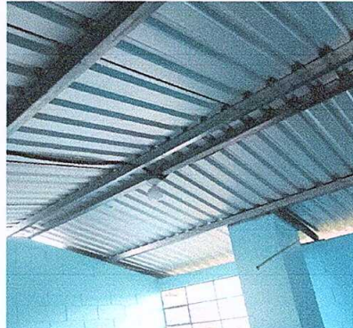
Foto 2: ESTRUCTURA DE TECHO
